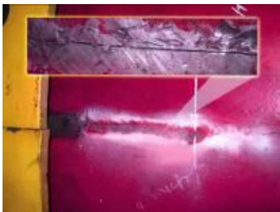
Трещина диаметального сварного шва лобовины
