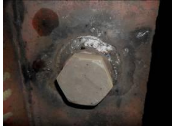
Швы после ремонта
