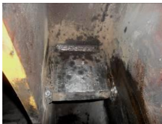
Швы после ремонта
