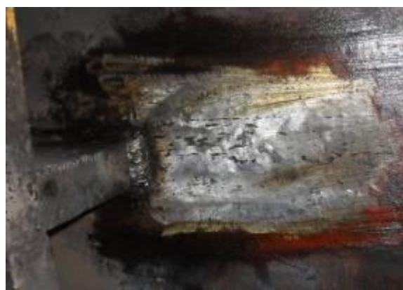
Шов после ремонта
